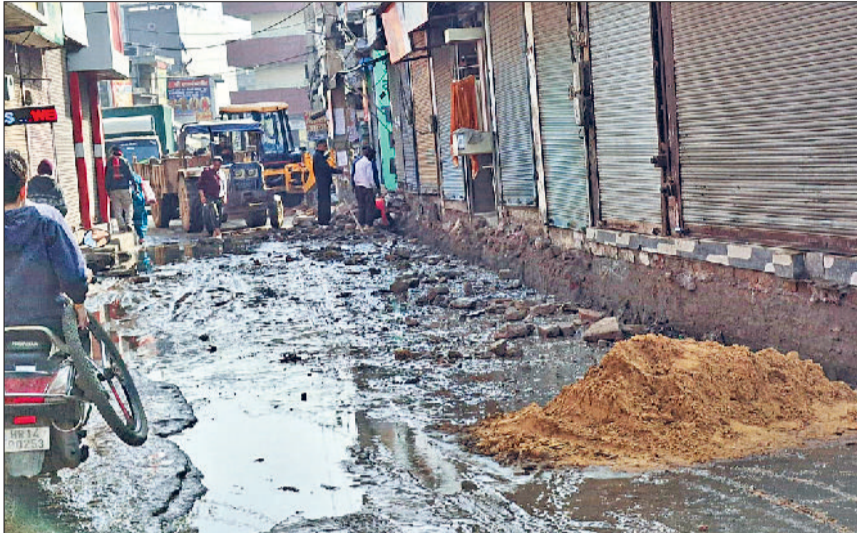
झज्जर। शहर के मेन बाजार में किया जा रहा नालों का निर्माण।
